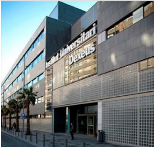
Figura 4. Vista de l'actual Institut Universitari USP Dexeus, al barri de Les Corts de Barcelona. 4
